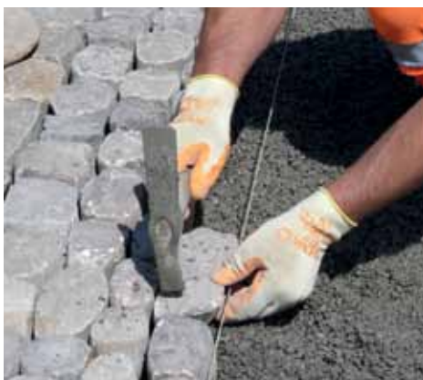
Versetzen der Wackensteine im Splittbett
