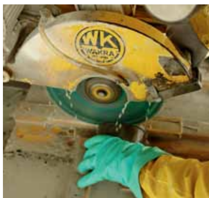
Die Wackensteine werden gesägt.
