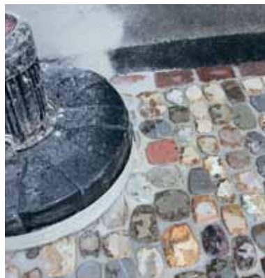
Maschinelles Schleifen bei großen Flächen
