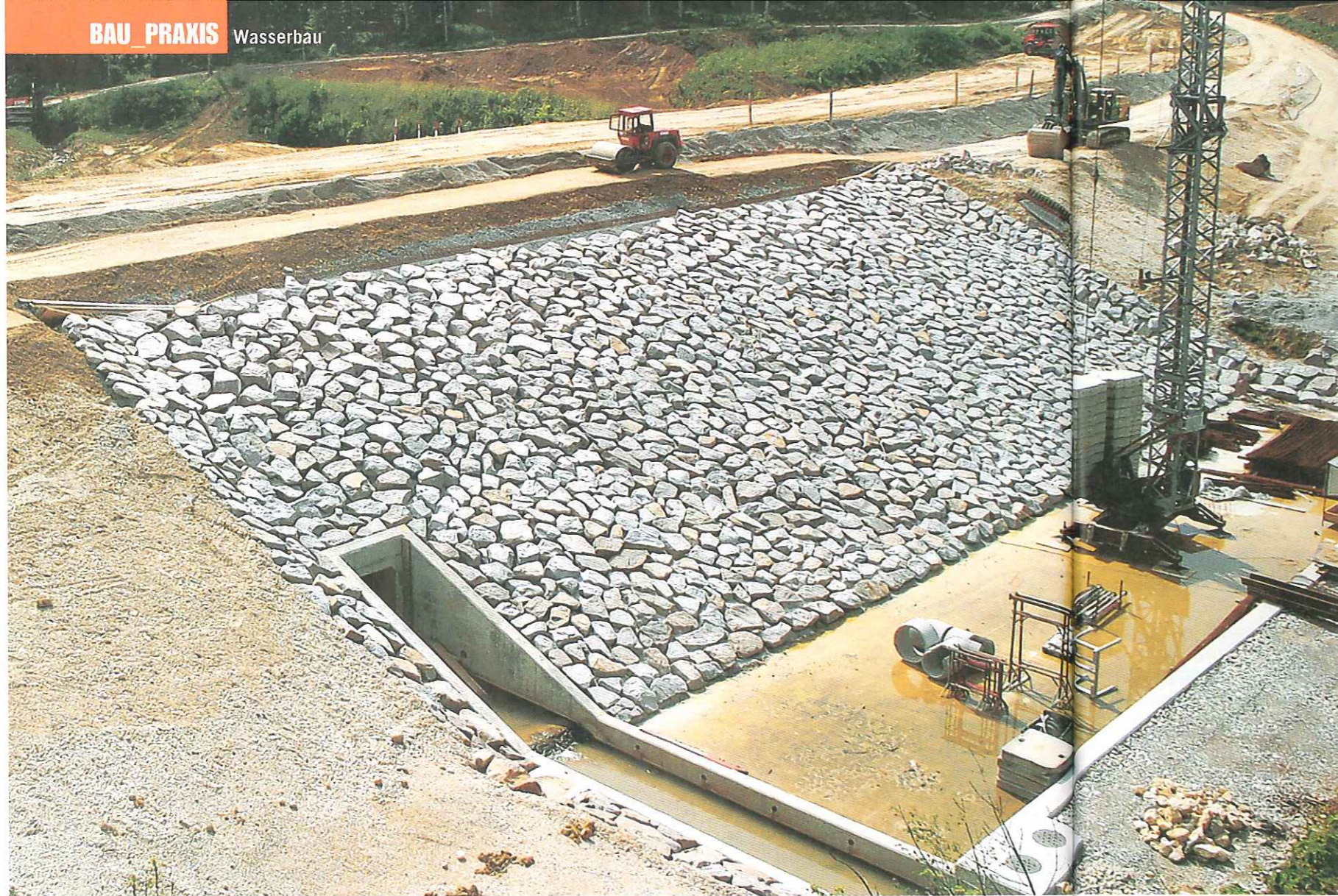
Die Hochwasserentlastung des Dammes umfasst in der Damm-Mitte ein breschenförmiges Transportgerinne mit einer 40 Meter breiten Überfallkante, die am Dammfuss in ein Tosbecken führt.
