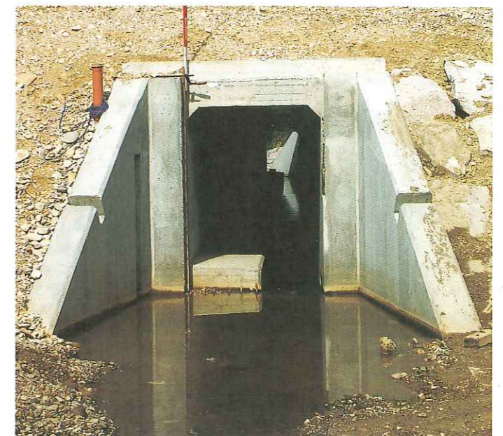
Der knapp 50 Meter lange Durchlass mit einem Querschnitt von 1,5 auf 2,4 Meter durchquert den Damm.
